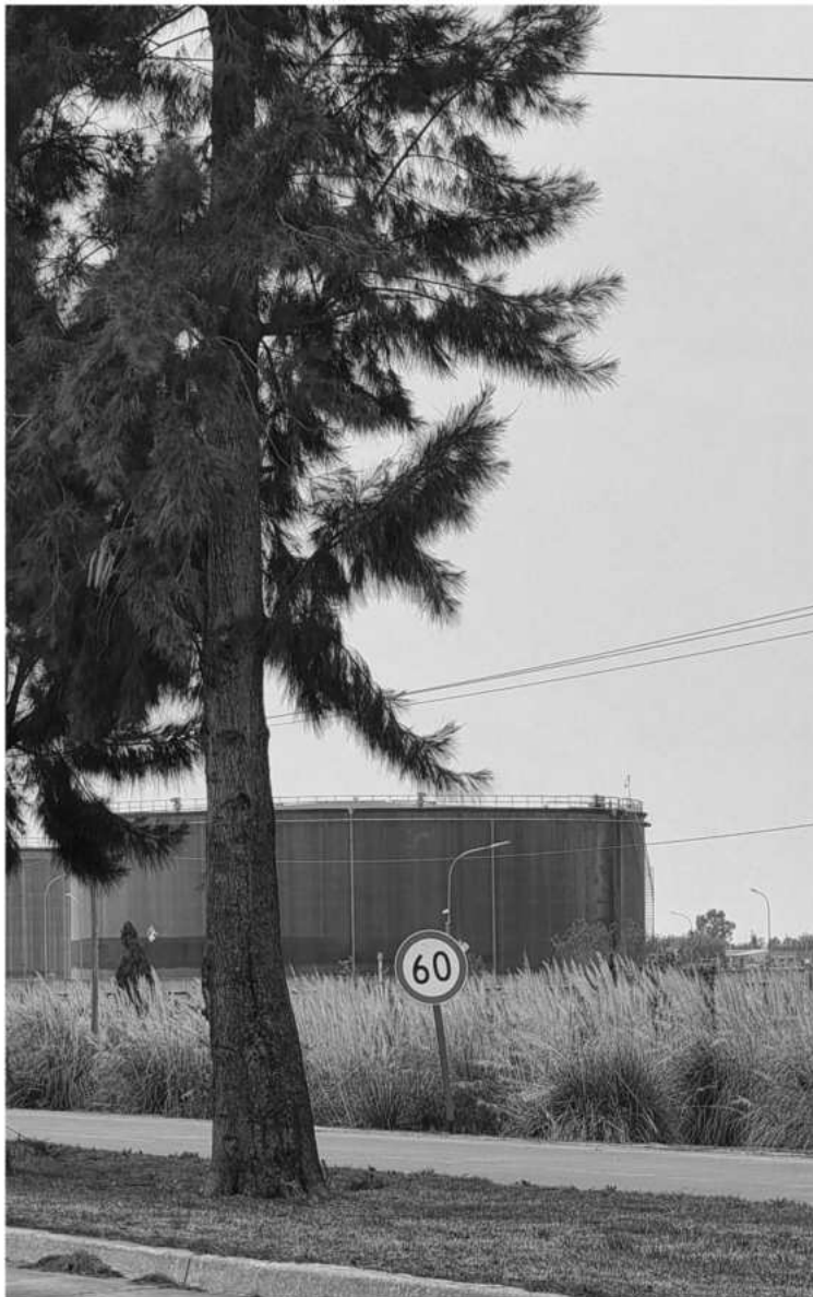
Av. Del Petróleo - Tanques de Almacenamiento
