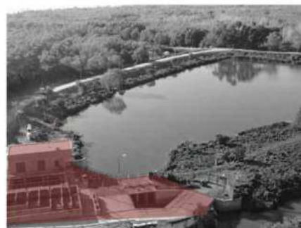
Estación de bombeo Nº1 - Terraplen de Berisso
