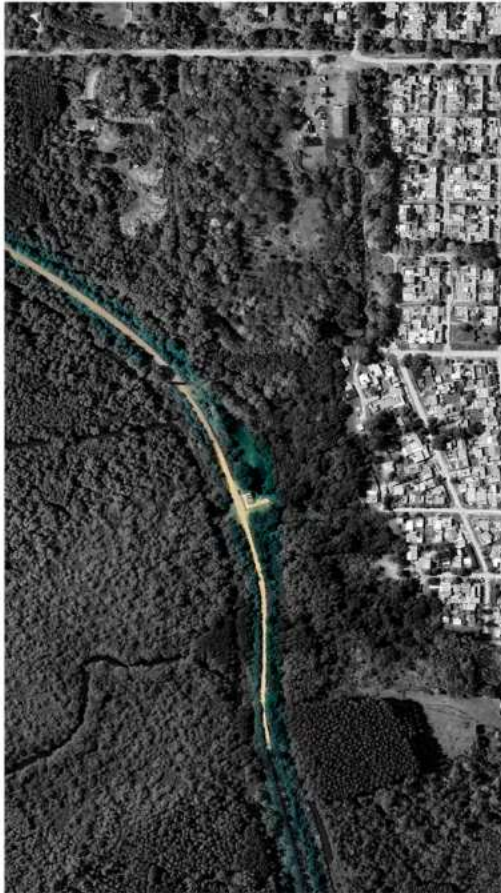
Estaciones de bombeo - Terrapien de Berisso
