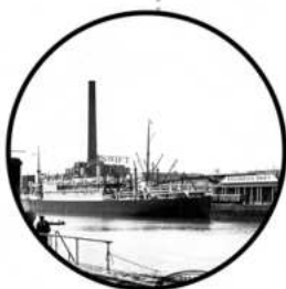
Ingreso de Barco de Carga al Frigorífico Swift (1925)
