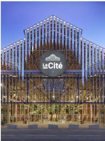
La Cité Innovation Hub / Taillandier Architectes Associés
