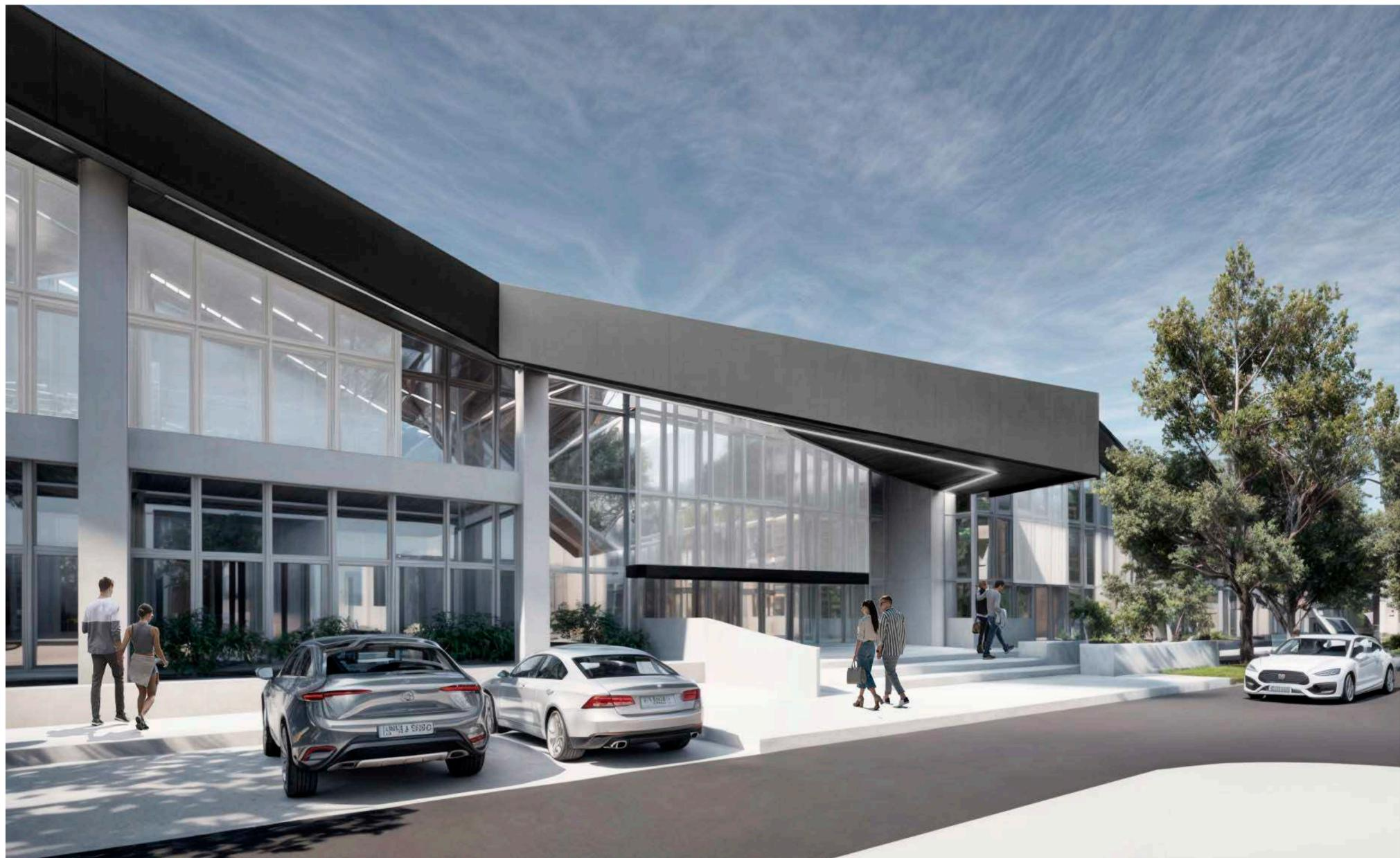
El proyecto se ordenará siguiendo una grilla modular regular y ortogonal que adoptará una luz de 7,20m, la cual se ajustará en determinados sectores según distintas necesidades proyectuales, sobre la cual se dispondrán los distintos elementos que conformen la estructura resistente del edificio.
