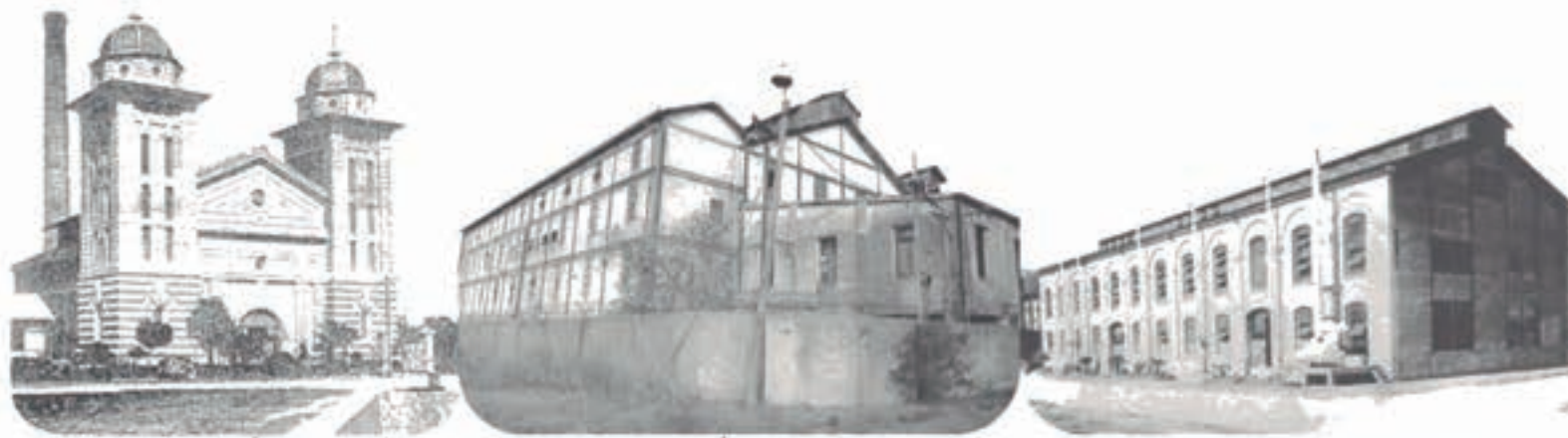
| CASA DE MÁQUINAS |
