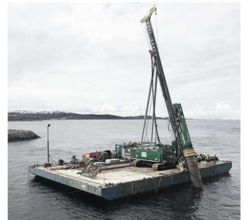
EQUIPO DE HINCADO DE PILOTES SOBRE PLATAFORMA FLOTANTE
