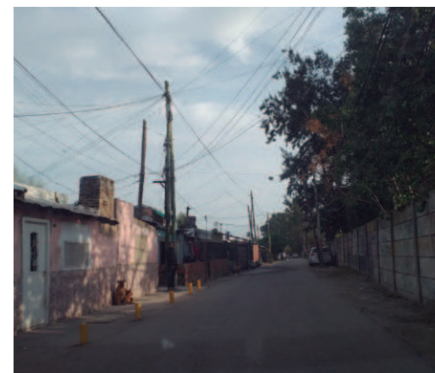
Muros que dividen al propio barrio, ausencia de veredas, límites poco definidos de donde empieza la calle y donde termina
