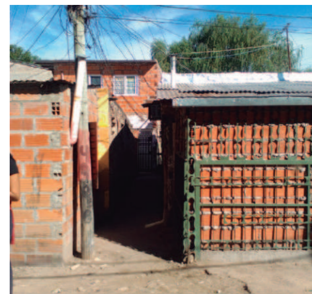
Pasillos/pasajes peatonales entre viviendas, ausencia de veredas, límites confusos entre lo público y lo privado
