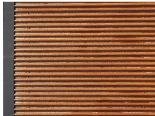
Imagen 40: Revest.ext. chapa acanalada acero corten
