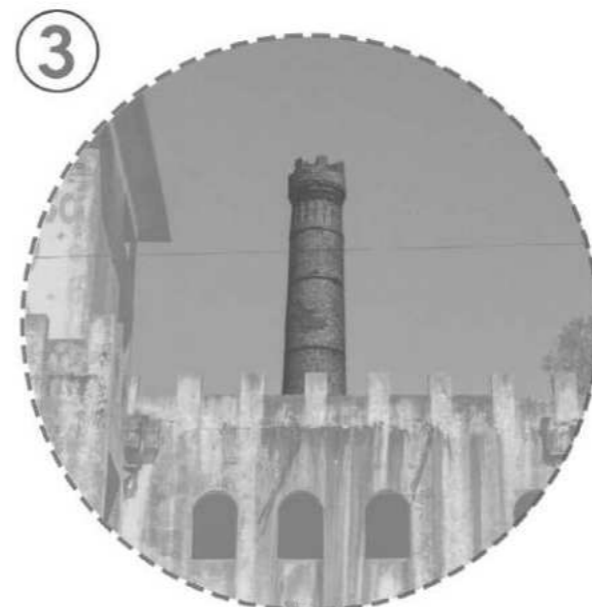
③ -CHIMENEA- Gran altura e imponencia (ladrillo visto)
