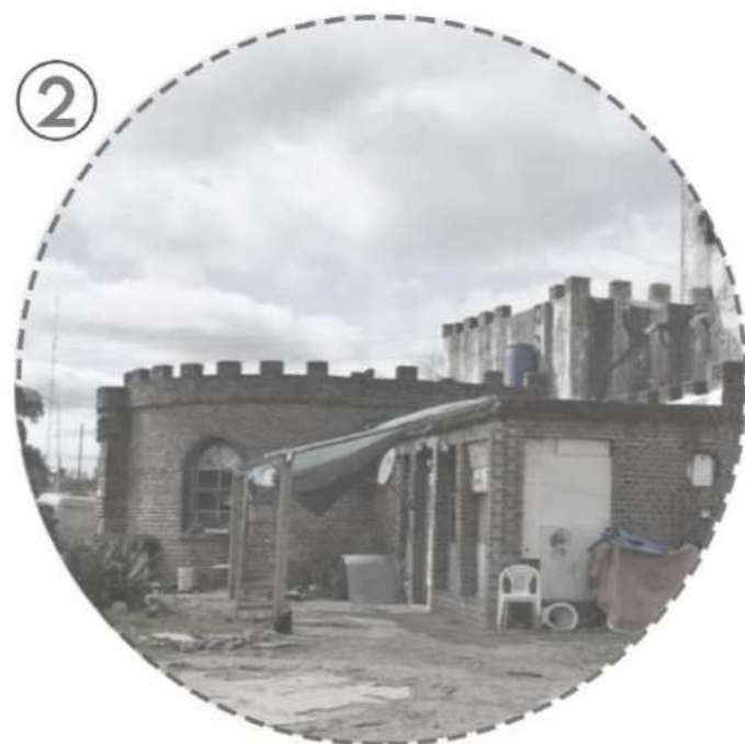
-BLOQUES ADICION- Tomados con familias viviendo en ellos
