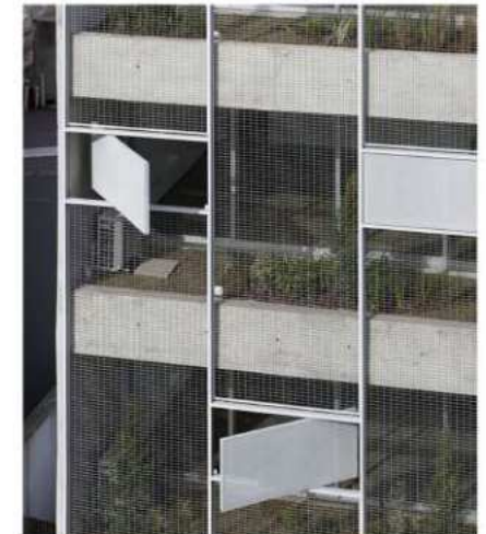
ENVOLVENTE. RED METÁLICA. Adamo Faiden Edificio Bondpland
