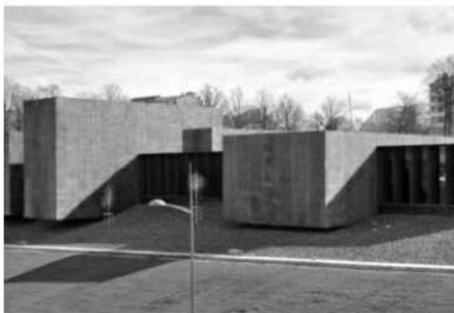
MUSEO SOULAGES, RODEZ. RCR ARQUITECTOS.
