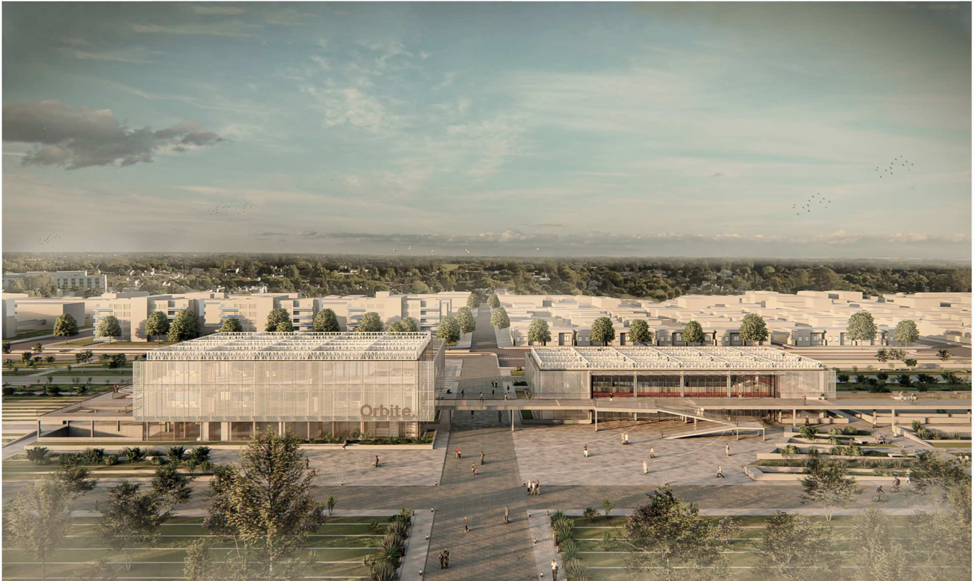
Imagen aérea donde se contempla la volumetría completa, los accesos y vínculos que tienen los edificios, tanto entre sí como con el entorno inmediato.
