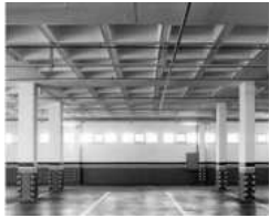
Losa casetonada en subsuelo
