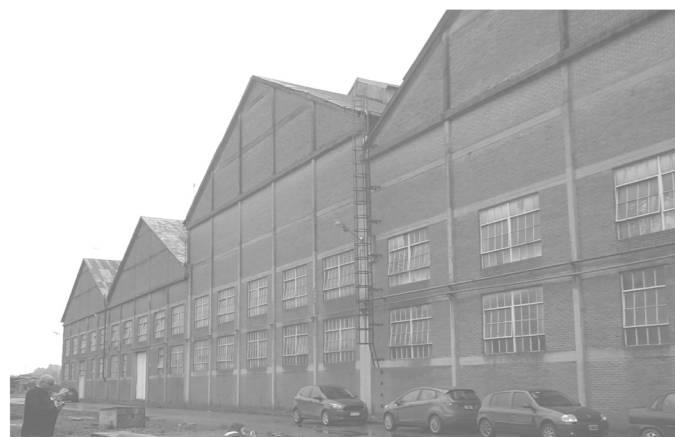
Cerramiento ladrillo visto
