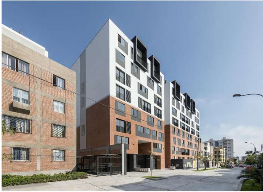
1) Conjunto residencial Tandem / Rodrigo Martínez / Arquitecto
