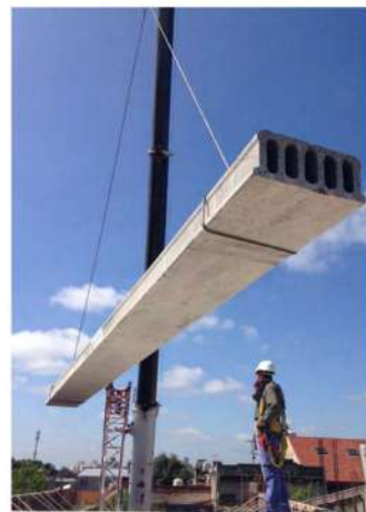
SISTEMA DE MONTAJE. ALREDEDOR DE 250M2 POR DIA DE COLOCAION
