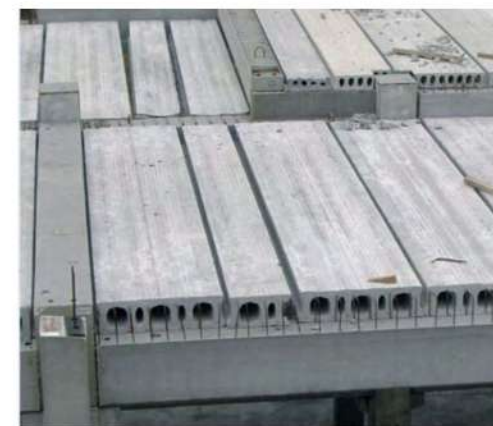
ENCUENTRO DE VIGAS, COLUMNAS Y LOSETAS. HIERRO SEGUN CALCULO.
