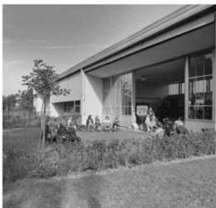
Escuela Corona, Richard Neutra. 1935 Los Angeles, California. Aulas distribuidas en forma de peine, grandes ventanales, mobiliario flexible, lugares de guardado. El espacio del aula permite la máxima libertad de uso y expansión al exterior, relación con la naturaleza.
