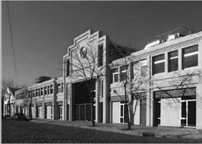
Nueva obra del edificio del ex Mercado de Pescado / Centro Metropolitano de Diseño (CMD)
