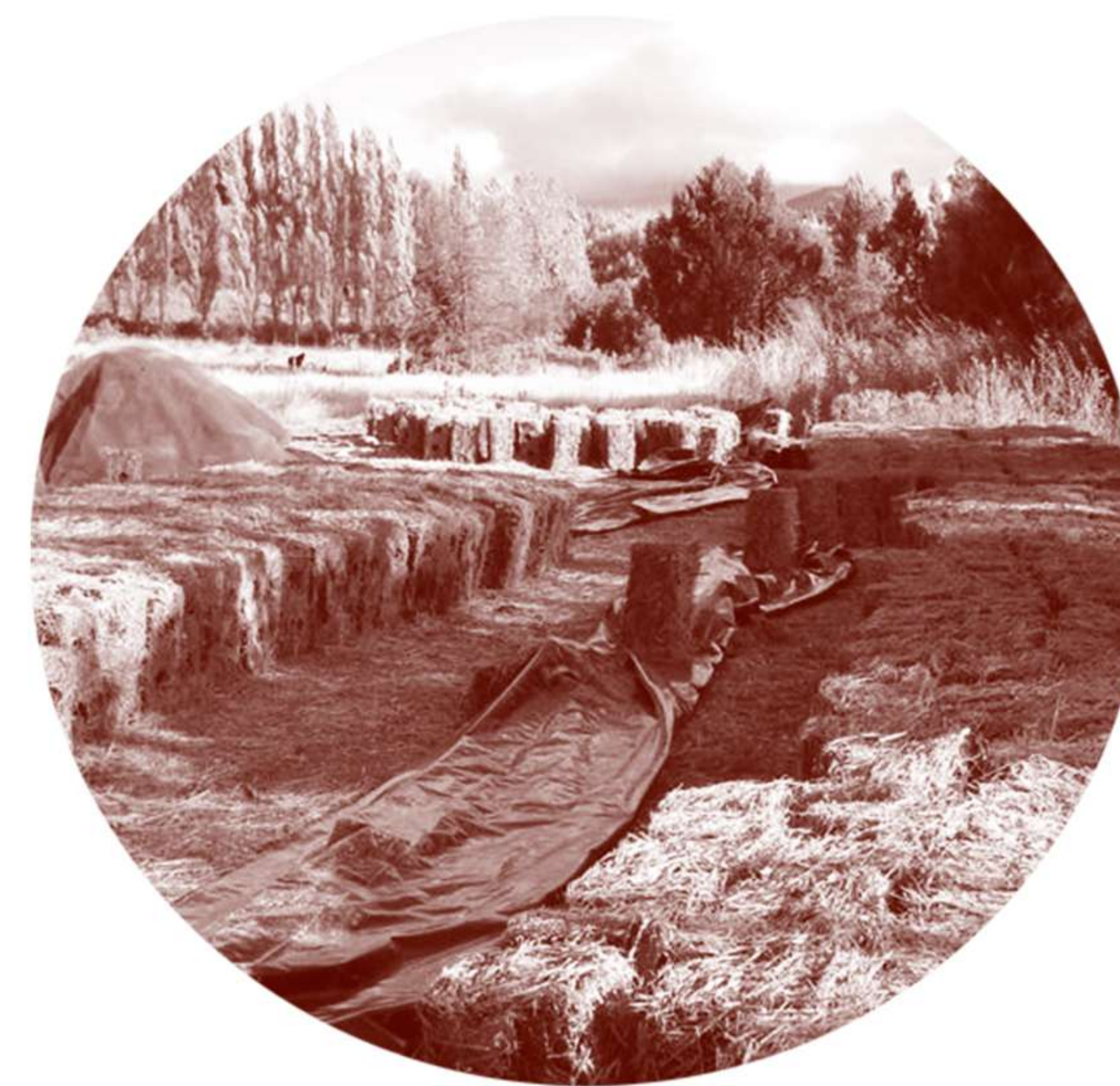
FARDOS DE PAJA SE USAN COMO AISLANTE BUEN DISEÑO TERMICO.
