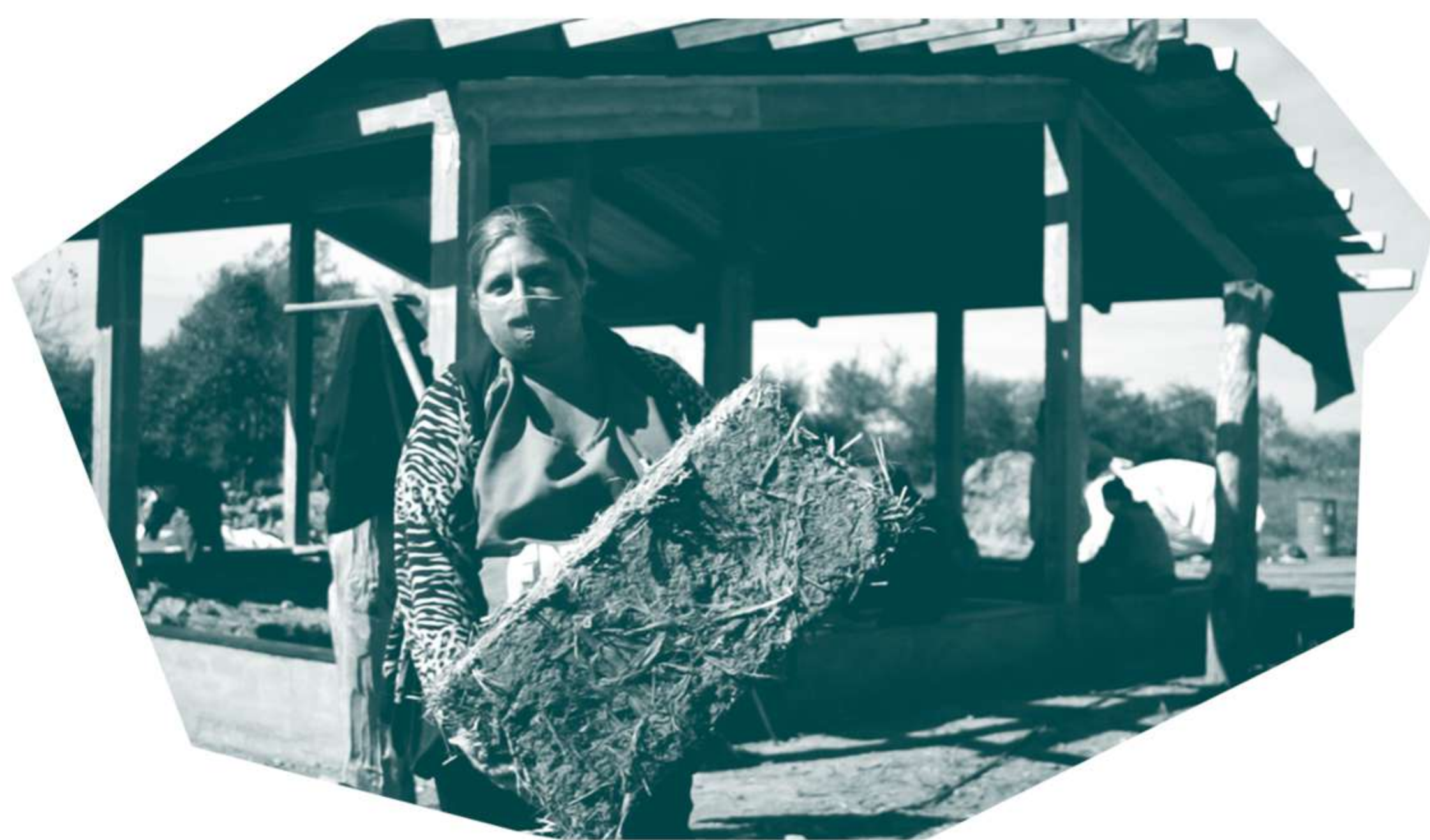
LADRILLOS DE ADOBE TIERRA + ARCILLA + FIBRA VEGETAL (PAJA DE TRIGO)
