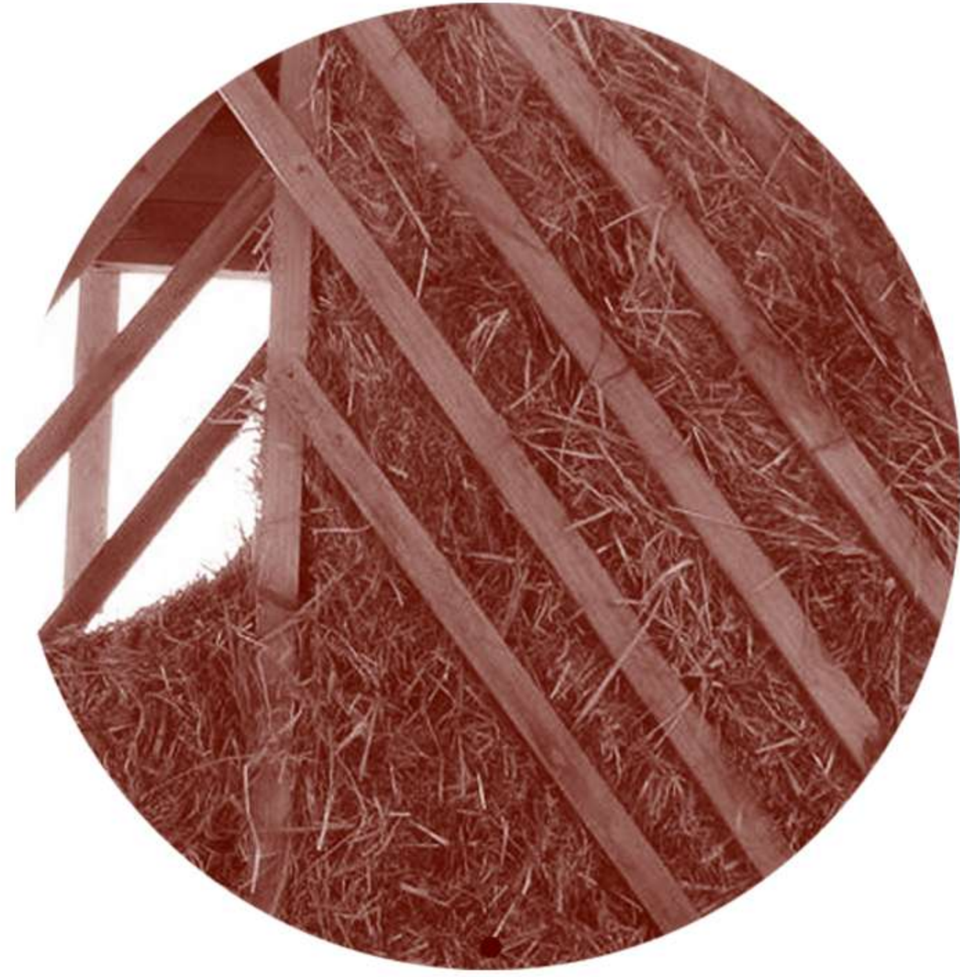
MURO DE QUINCHA
