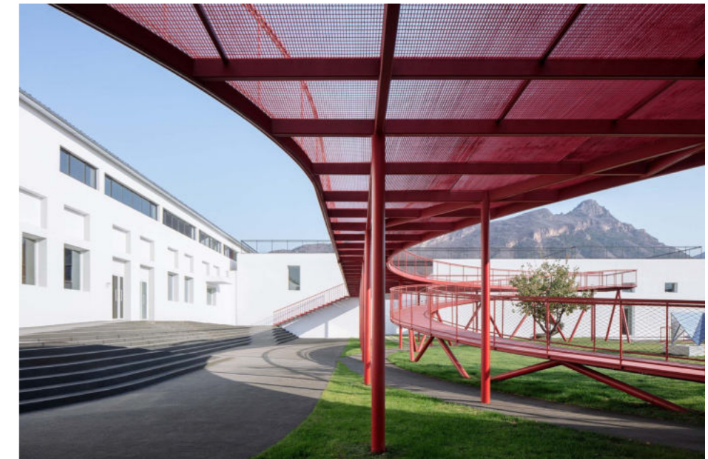
5- NUEVA PASARELA METÁLICA
