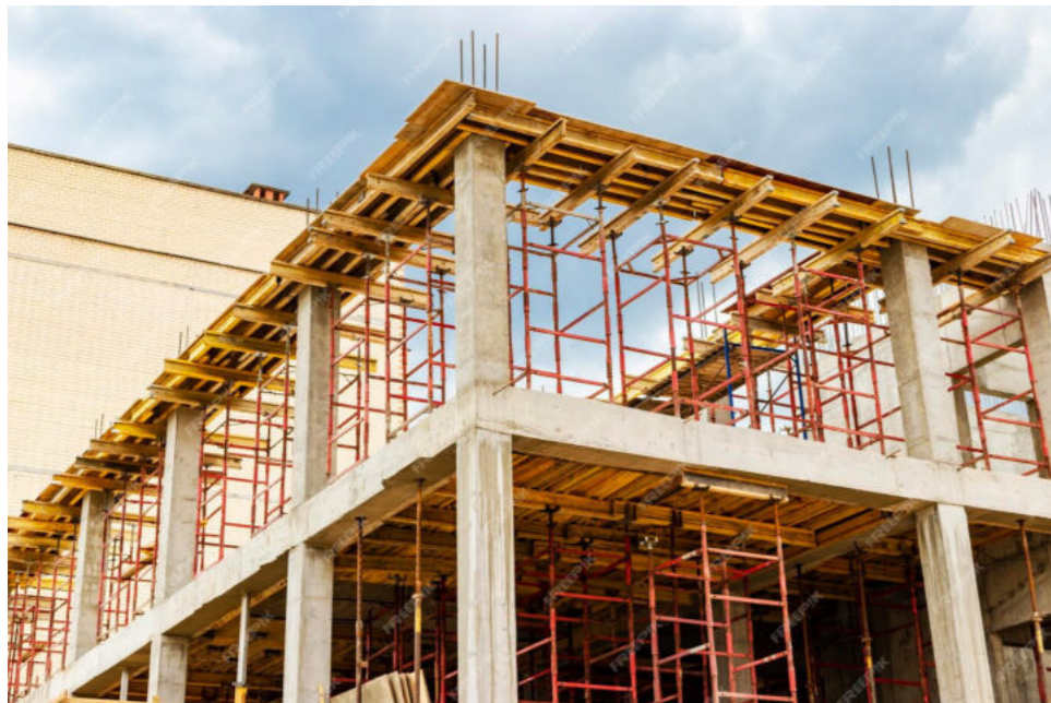
3- COLUMNAS, VIGAS Y LOSAS
