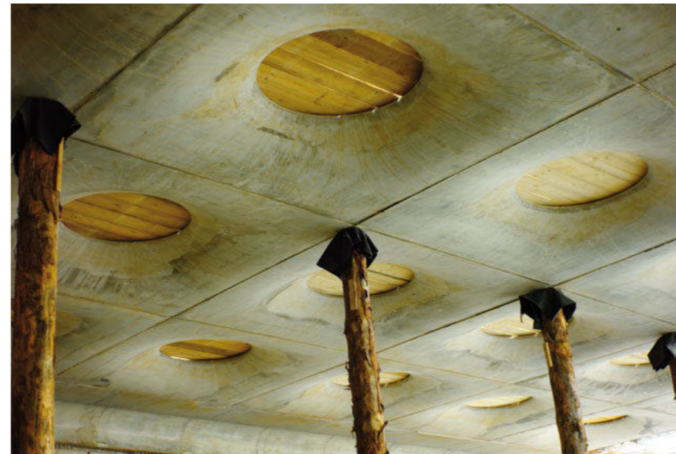
4- EMPARRILLADO CUBIERTA PILETA
