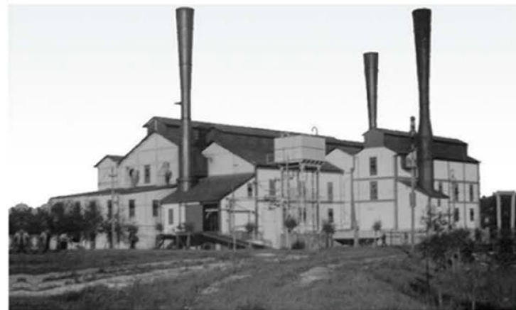
| USINA ELECTRICA PUERTO LA PLATA |
