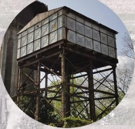
2-TANQUE DE AGUA
