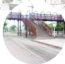
9- PUENTE PEATONAL METALICO
