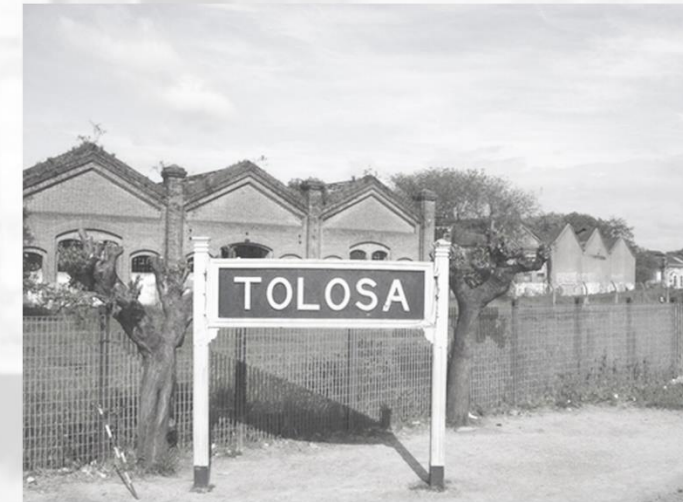
Talleres ferroviarios lindantes a la estación
