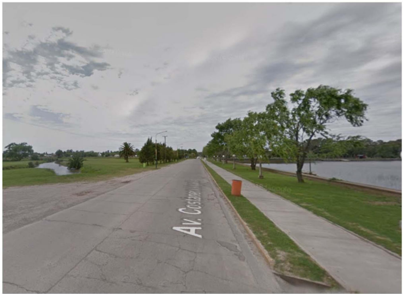
Avenida Costanera arroyo entubado.
