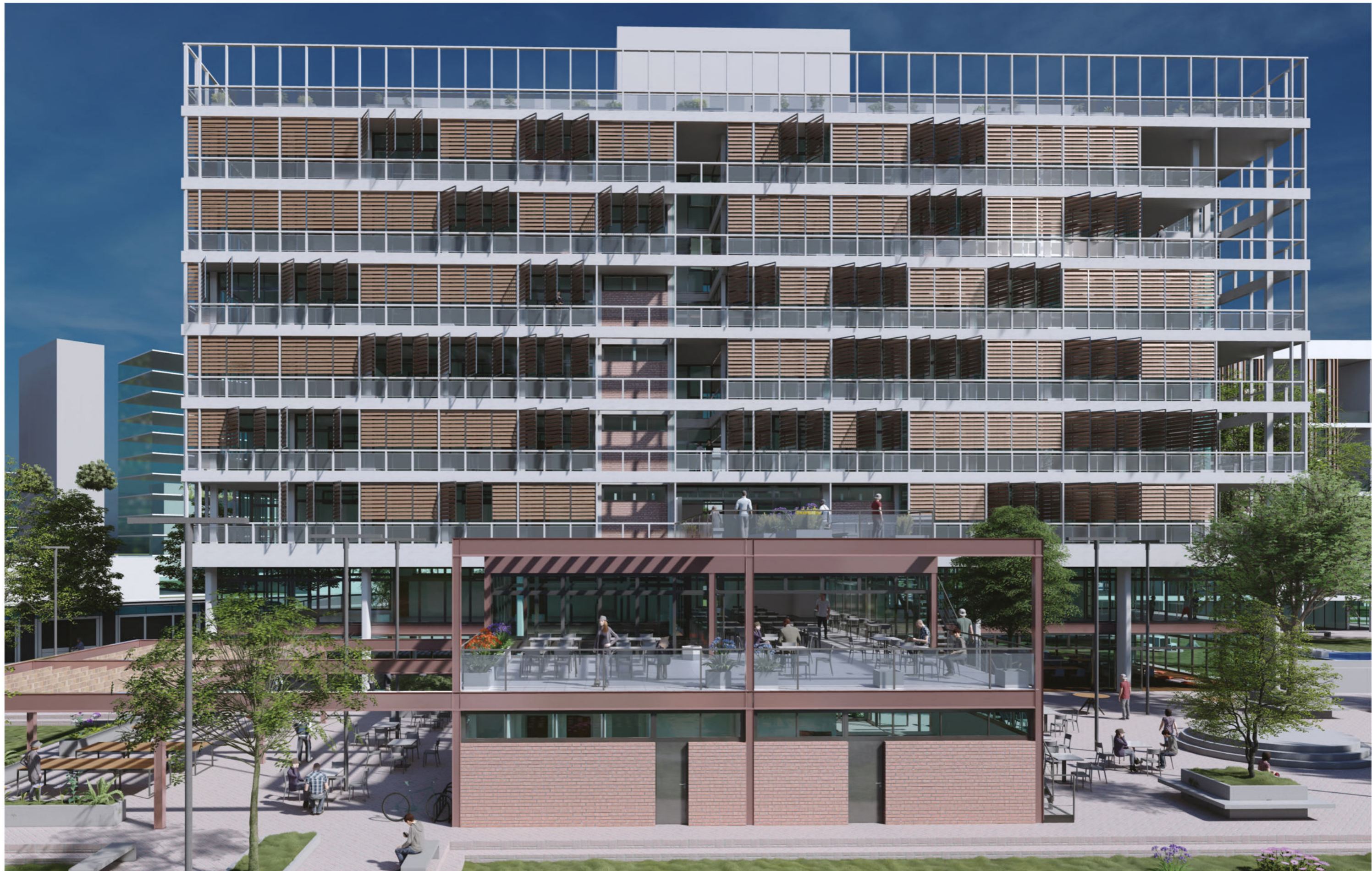
Desde lateral comedor comunitario Usos generales del sector público. Vista del conjunto general.
