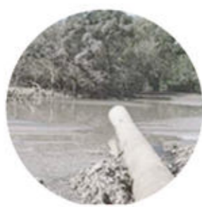
Descarga de refulado (dragado)
