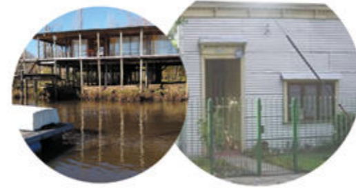
Arquitectura vernácula. Estructura palafítica y revestimiento de chapa
