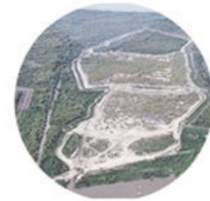
Explotación de hectáreas de la Isla Paulino. Canteras para extracción de tosca para rellenos y subrasantes de caminos
