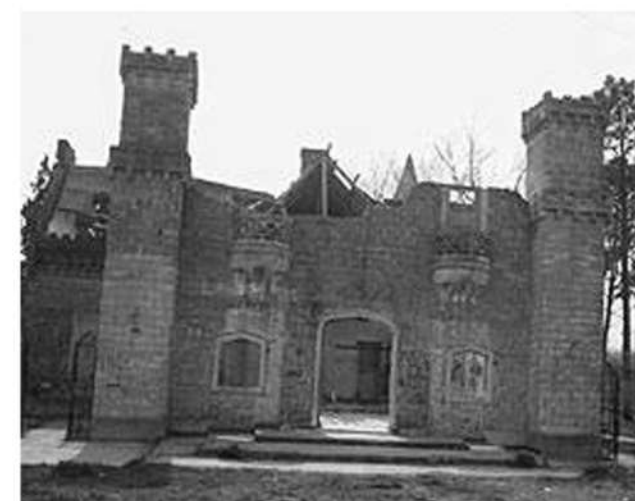
Deterioro luego de la caída del reino
