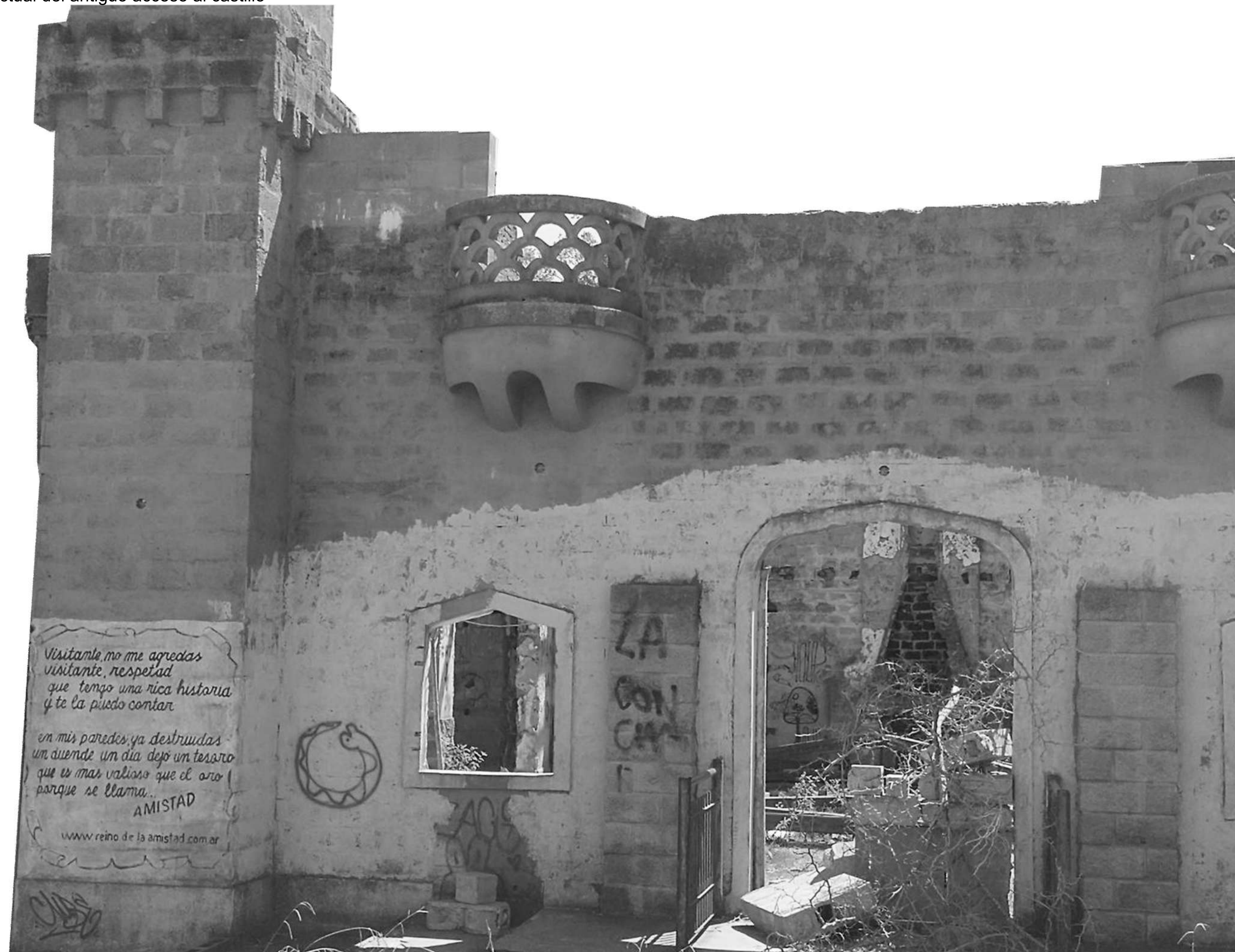
Fachada estado actual del antiguo acceso al castillo
