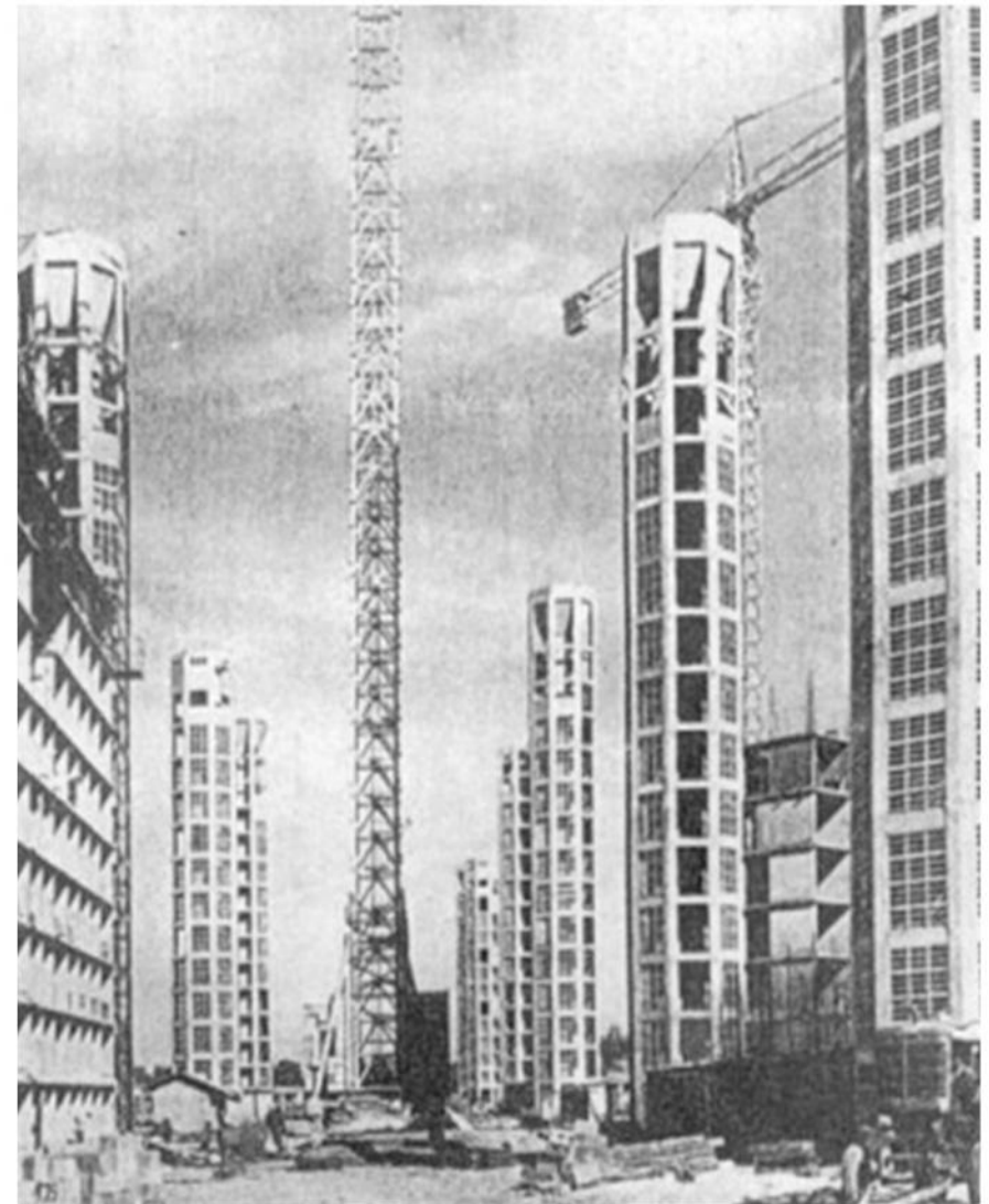
FOTO DE LA CONSTRUCCIÓN DEL BARIO PIEDRABUENA 1981
