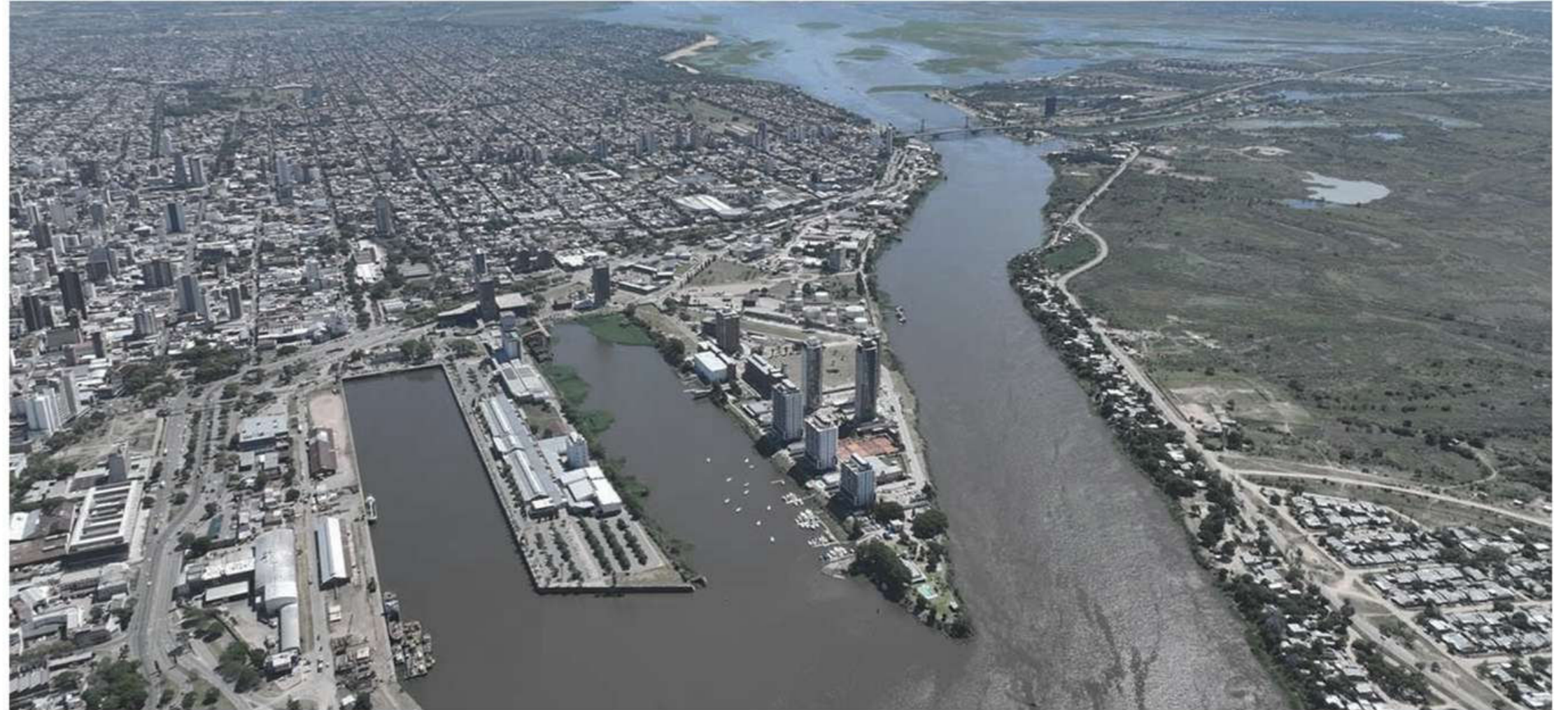
Area de intervencion: Puerto de Santa Fe
