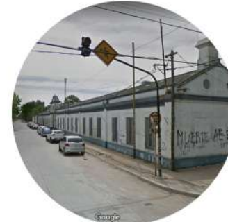
Deterioro de veredas
