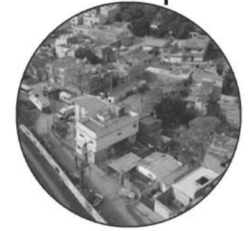
ASENTAMIENTO INFORMAL (BARRIO JOSE LUIS CABEZAS)
