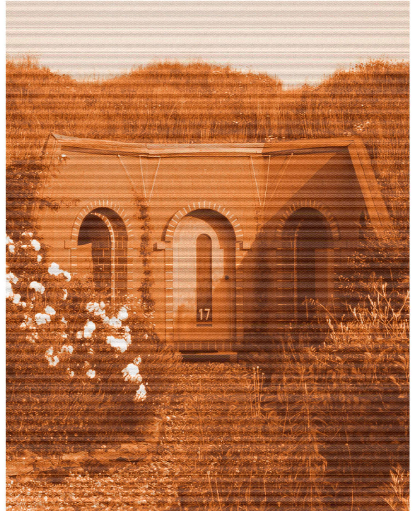
Casa de Gernot Minke en Alemania, construida en la década de 1970
