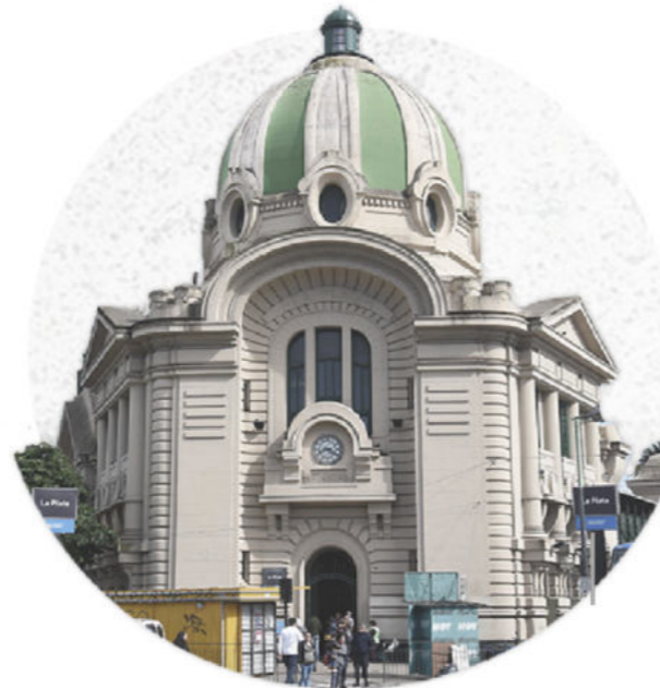
ESTACIÓN DE TREN ROCA
