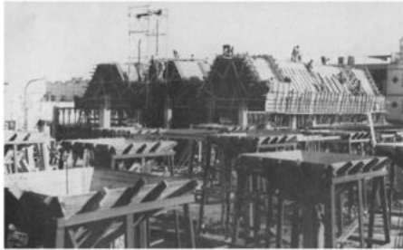
Centro deportivo Mülimatt - Arq Vacchini 2010 Láminas plegadas ensabladas en obra.
