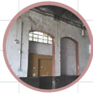
MUROS CON REVOQUE
