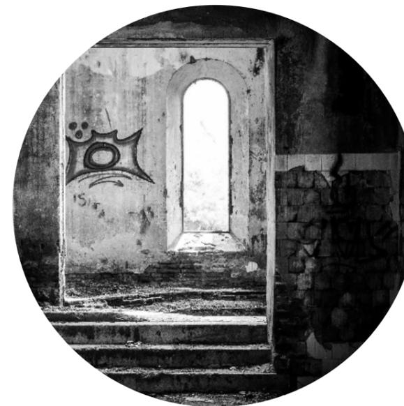
Revoques sin material y con ladrillos expuestos
