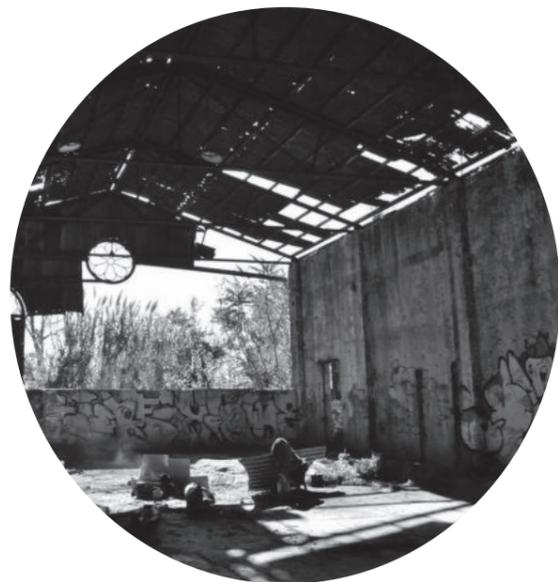
Cubierta y revestimiento de chapa deteriorados
