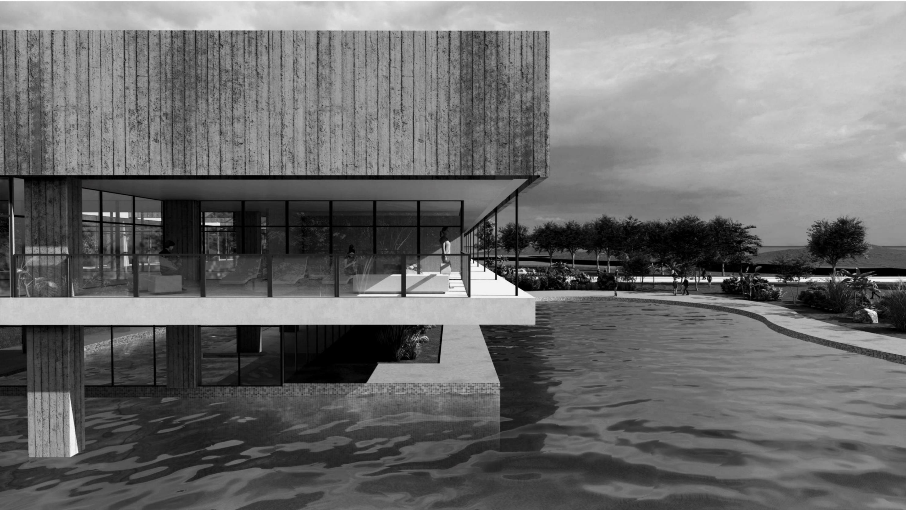
El lenguaje es la resultante de los elementos de la arquitectura que conforman el proyecto de hormigón armado en voladizo y el vidrio retraído como protección solar.
