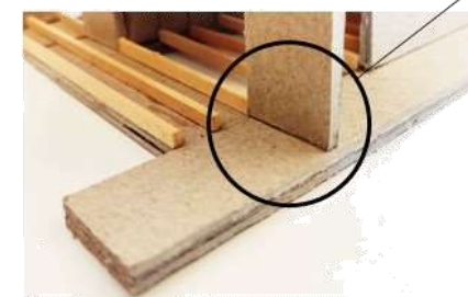
Detalle encuentro muro-zapata
