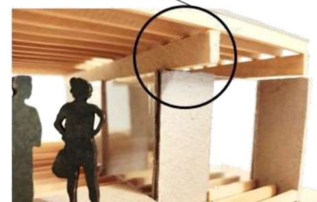
Detalle encuentro viga-muro
