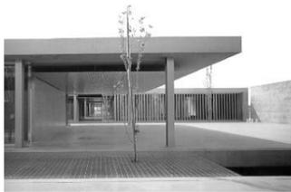
CONSTRUIDO APROVECHANDO UN PILOTAJE EXISTENTE, DESARROLLA UN ESQUEMA ESTRUCTURAL QUE LE LIBERA DE LA TRAMA DE APOYOS Y LE PERMITE DISPONERSE SOBRE EL SUELO CON UNA MAYOR LIBERTAD DE FORMA.
