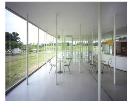
LA DISTRIBUCIÓN DE LOS PILARES EN PLANTA SE ORGANIZA A PARTIR DE UNA RETÍCULA DE 1,20 X 1,20 M, EN LA QUE SE ELIMINAN GRAN PARTE DE LOS PUNTOS, MANTENIENDO UNA CIERTA UNIFORMIDAD EN EL PERÍMETRO EXTERIOR, EN EL QUE LOS PILARES FORMAN UN PERISTILO, Y ADOPTANDO UNA MAYOR LIBERTAD EN EL ESPACIO INTERIOR, EN EL QUE LA RETÍCULA SE ADAPTA A SU CONFIGURACIÓN Y DISTRIBUCIÓN
